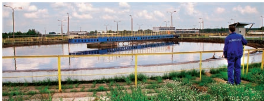
Oczyszczalnia ścieków w Radomiu
