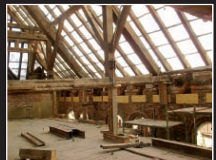
Nowy Port – prace w budynku łaźni miejskiej przy ulicy Strajku Dokerów. Będzie zaadaptowany na cele kulturalno- społeczne
