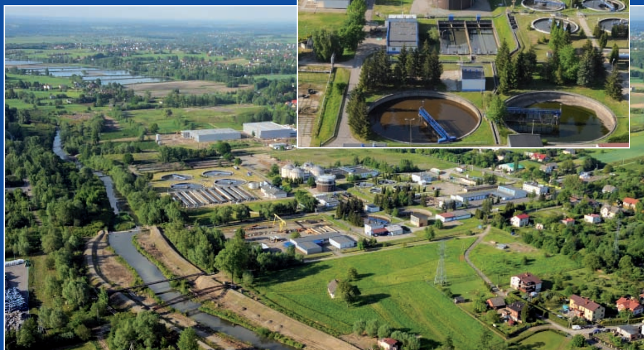
Oczyszczalnia ścieków Komorowice
