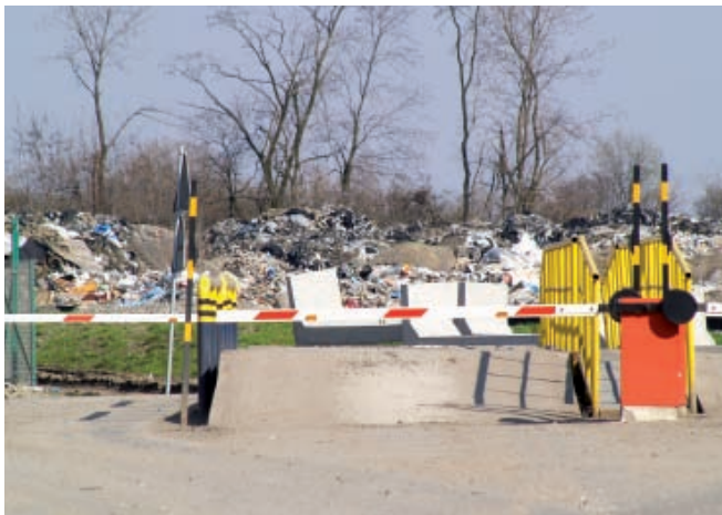
Brama wjazdowa do „nowoczesnej” sortowni w Chorzowie
