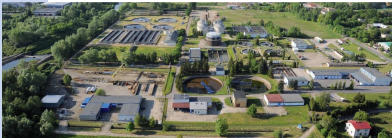
Oczyszczalnia ścieków w Komorowicach
