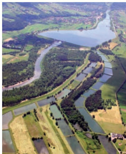
Ujęcia infiltracyjne w Kobiernicach
